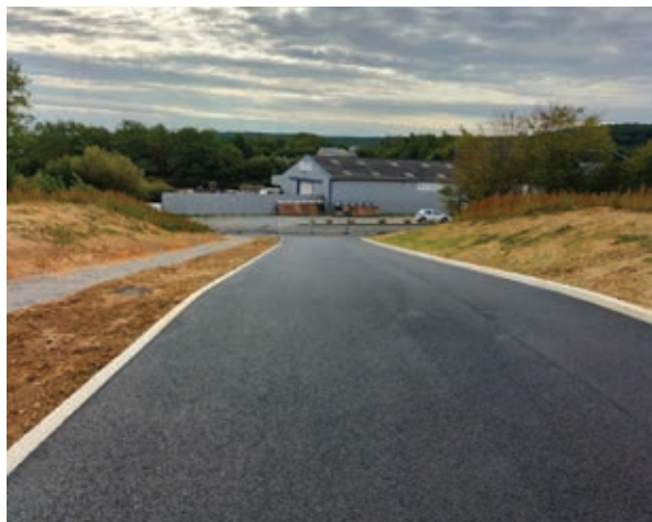
Travaux d'extension de la zone d'activités du Bray
