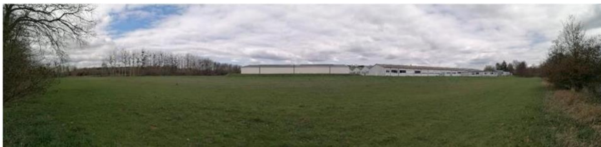
Figure 34 Vue de l'usine et des parcelles B0339 et B0340
