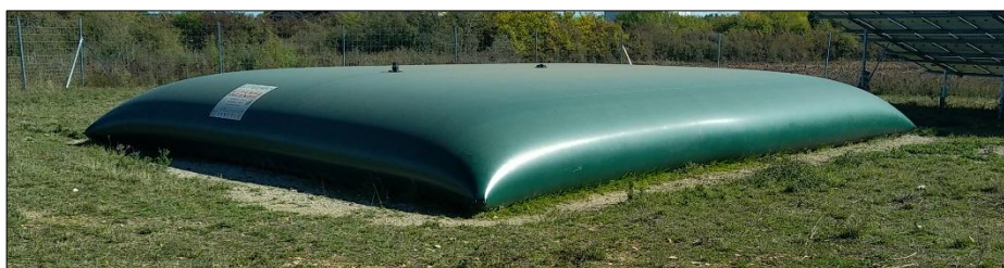
Figure 32 : Exemple photographique d'une citerne souple (source : COMIREM SCOP)
