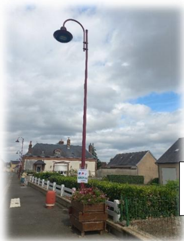
Passage de l'éclairage public en plateau LED
