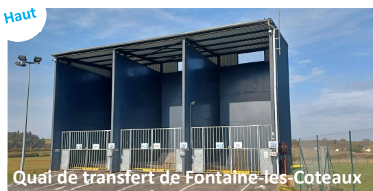
Transfert des OMr* et emballages
