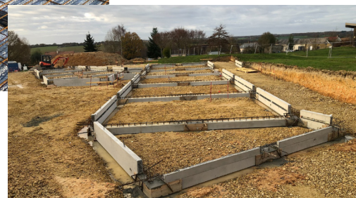
Coulage des dalles
