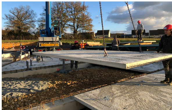
Pose des plaques de structure en circonférence
