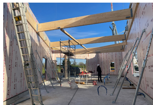
Pose des mobs et de la charpente en ossature bois
