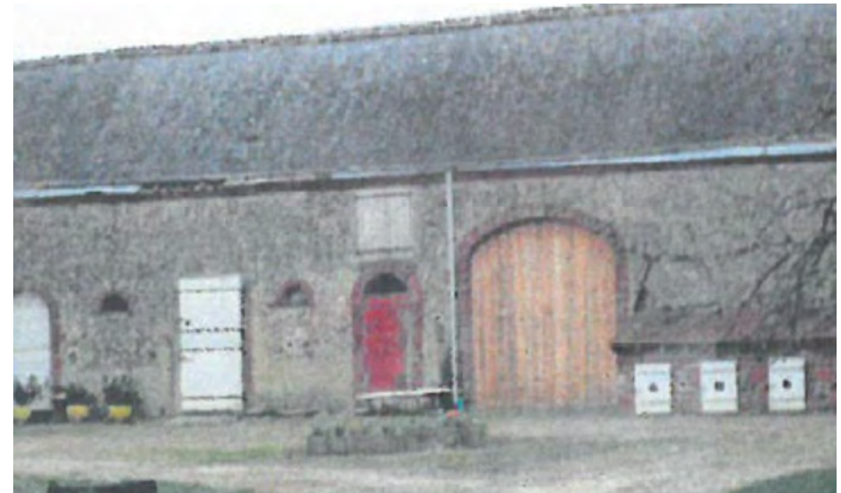
Photographie du bâtiment
