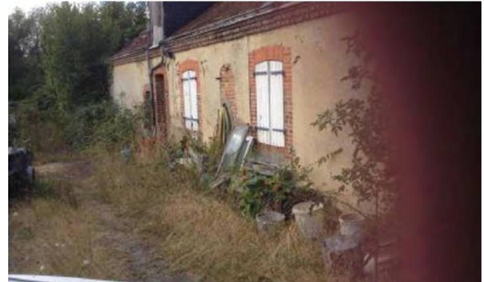
Photographie du bâtiment
