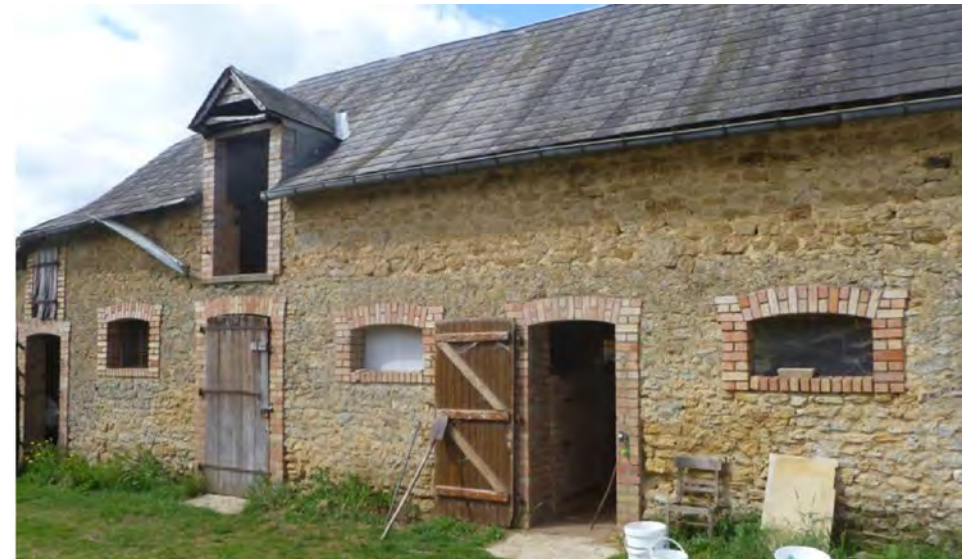
Photographie du bâtiment
