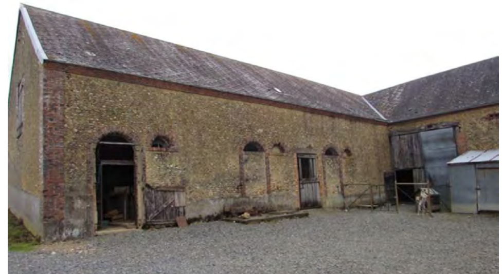
Photographie du bâtiment
