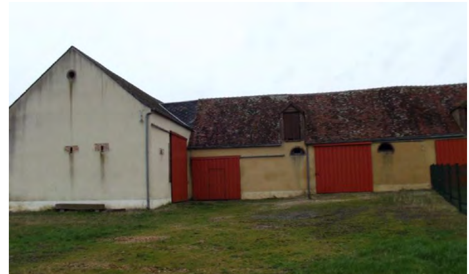
Photographie du bâtiment
