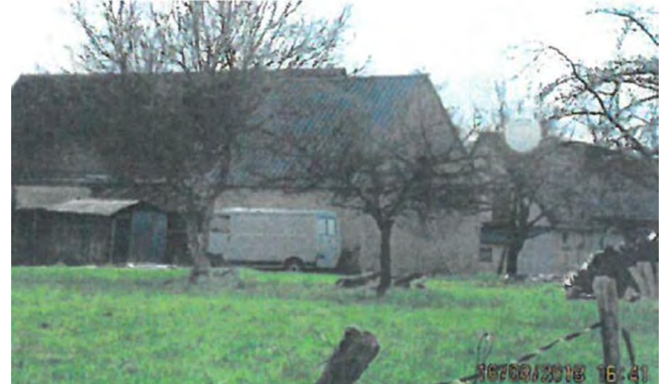
Photographie du bâtiment
