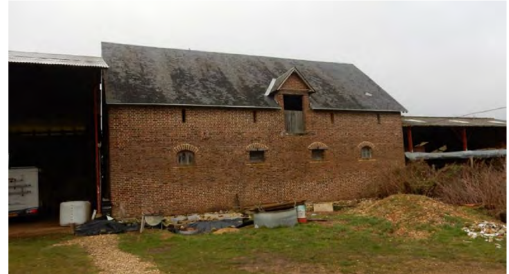
Photographie du bâtiment
