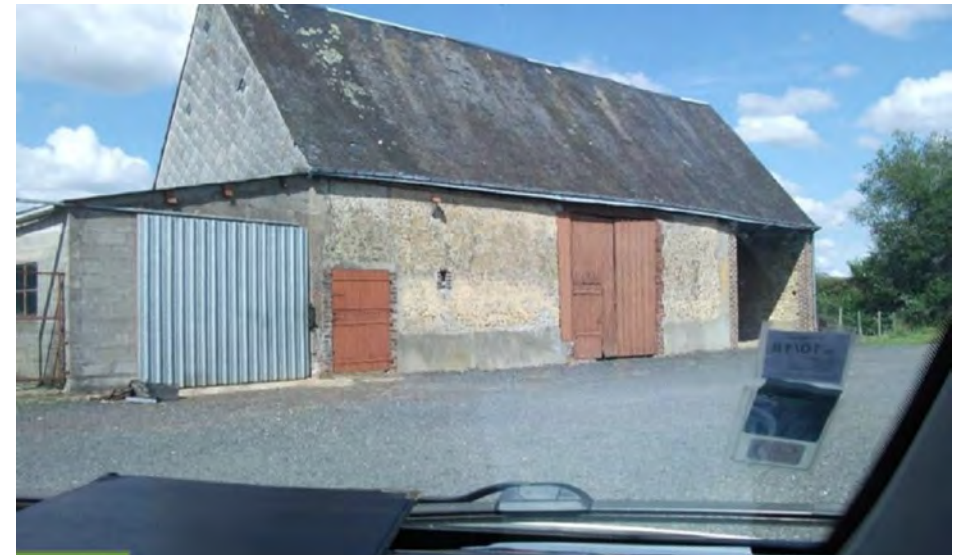
Photographie du bâtiment
