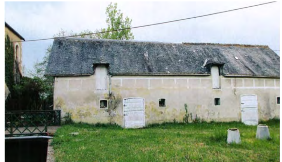
Photographie du bâtiment
