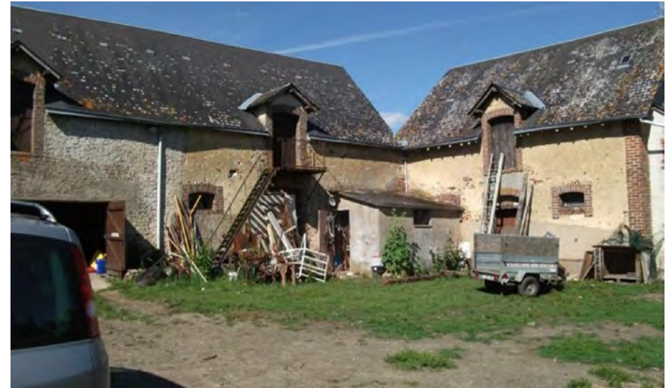
Photographie du bâtiment
