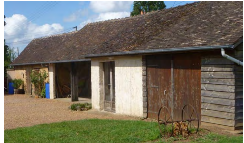
Photographie du bâtiment
