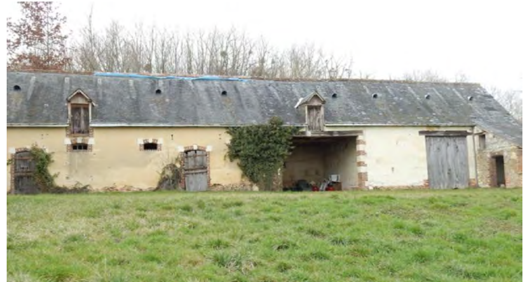
Photographie du bâtiment
