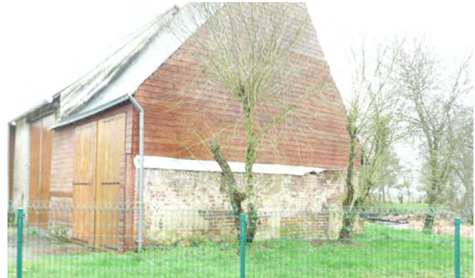
Photographie du bâtiment
