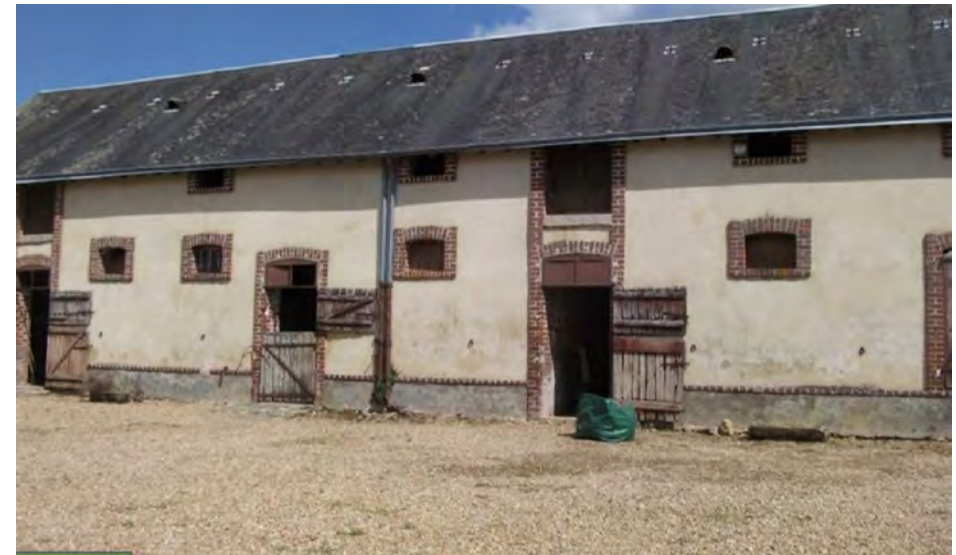
Photographie du bâtiment
