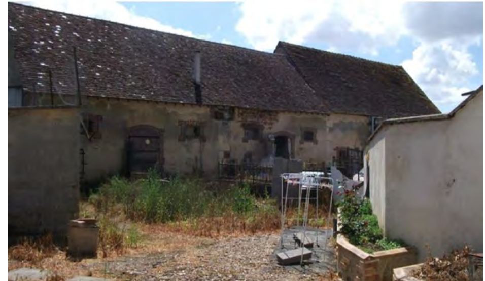
Photographie du bâtiment
