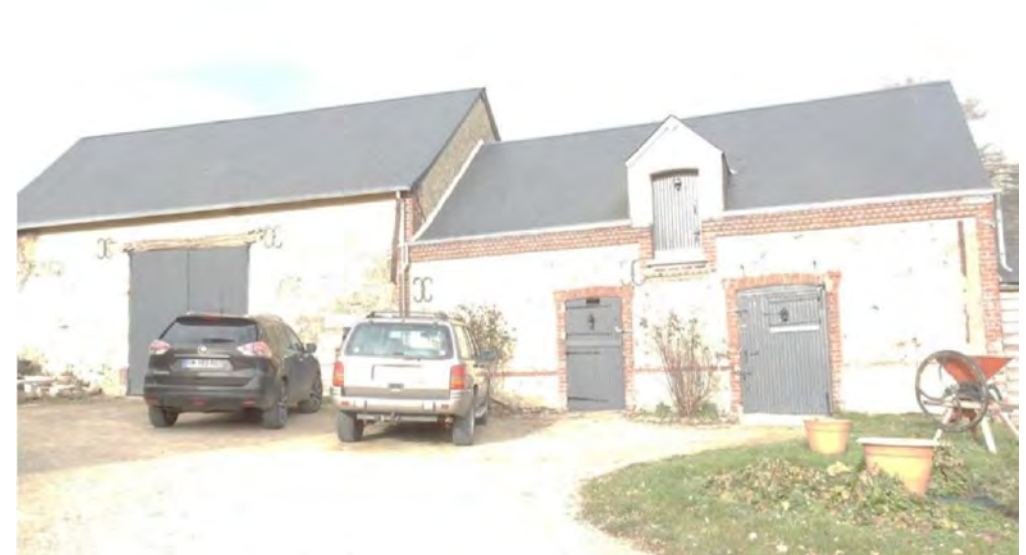
Photographie du bâtiment
