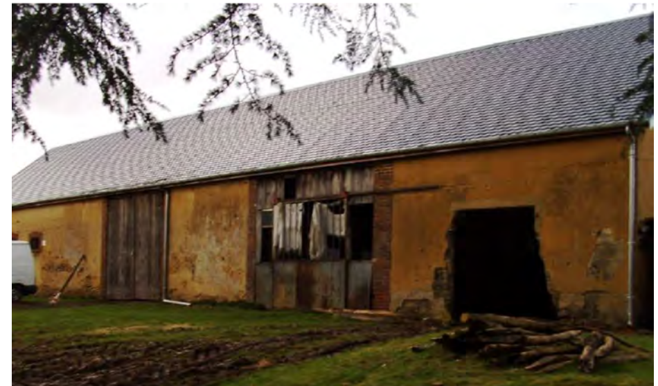
Photographie du bâtiment
