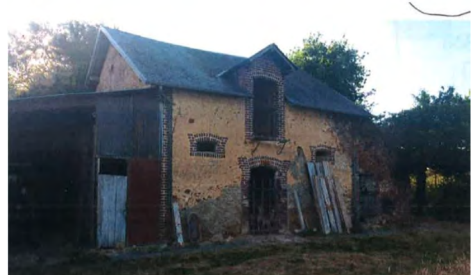
Photographie du bâtiment
