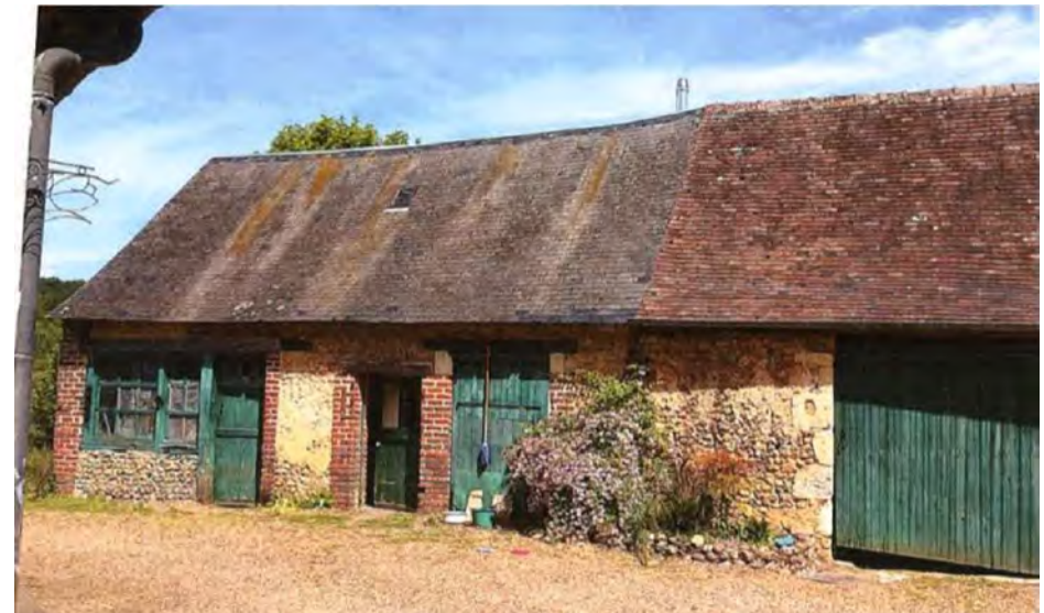
Photographie du bâtiment
