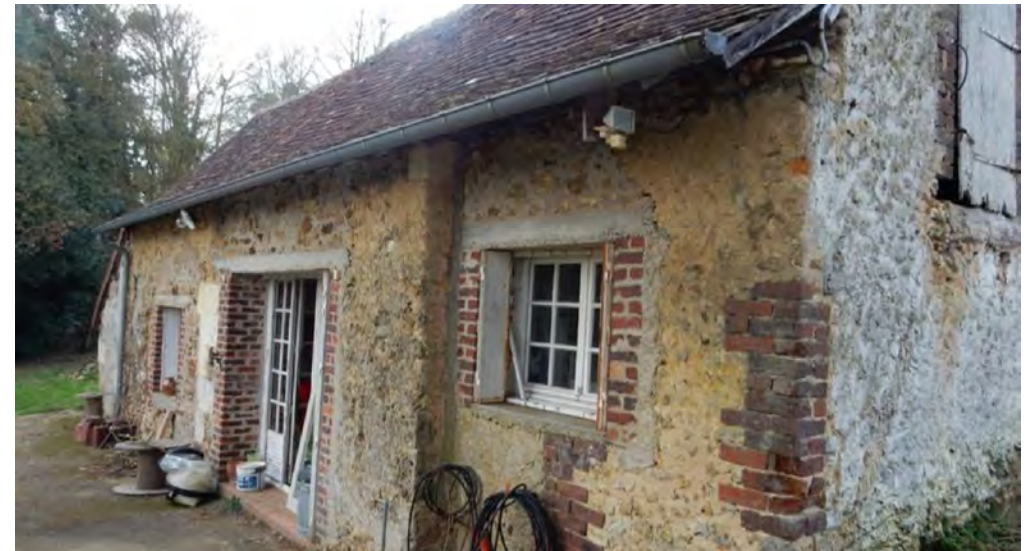
Photographie du bâtiment
