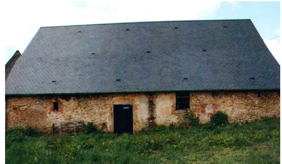
Photographie du bâtiment
