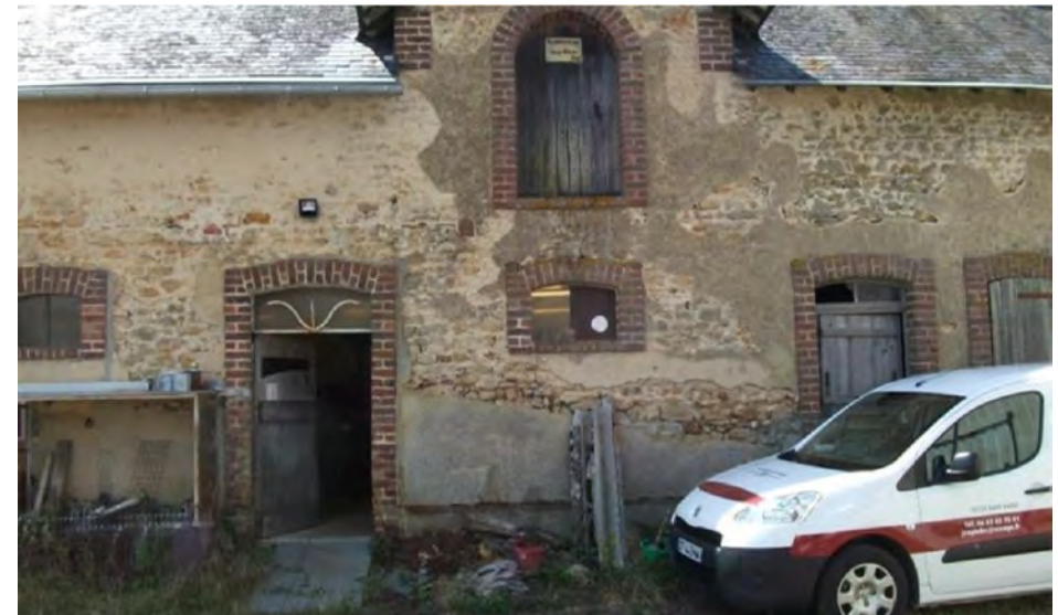
Photographie du bâtiment
