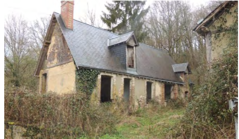
Photographie du bâtiment
