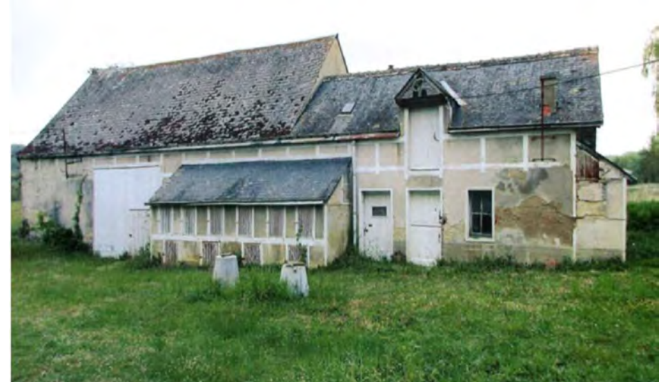
Photographie du bâtiment
